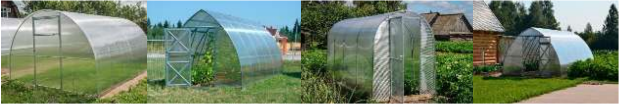
Рисунок 1 – Теплицы с покрытием из поликарбоната различной конструкции
